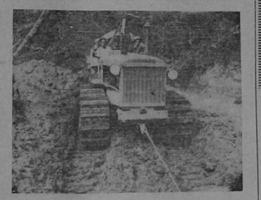
Con máquinas como ésta — monstruos de acero motorizados — se está transformando la faz de la tierra, al sur del Cerro de la Muerte. Esta máquina está abriendo la trocha.
